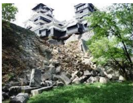
熊本城石垣崩落
